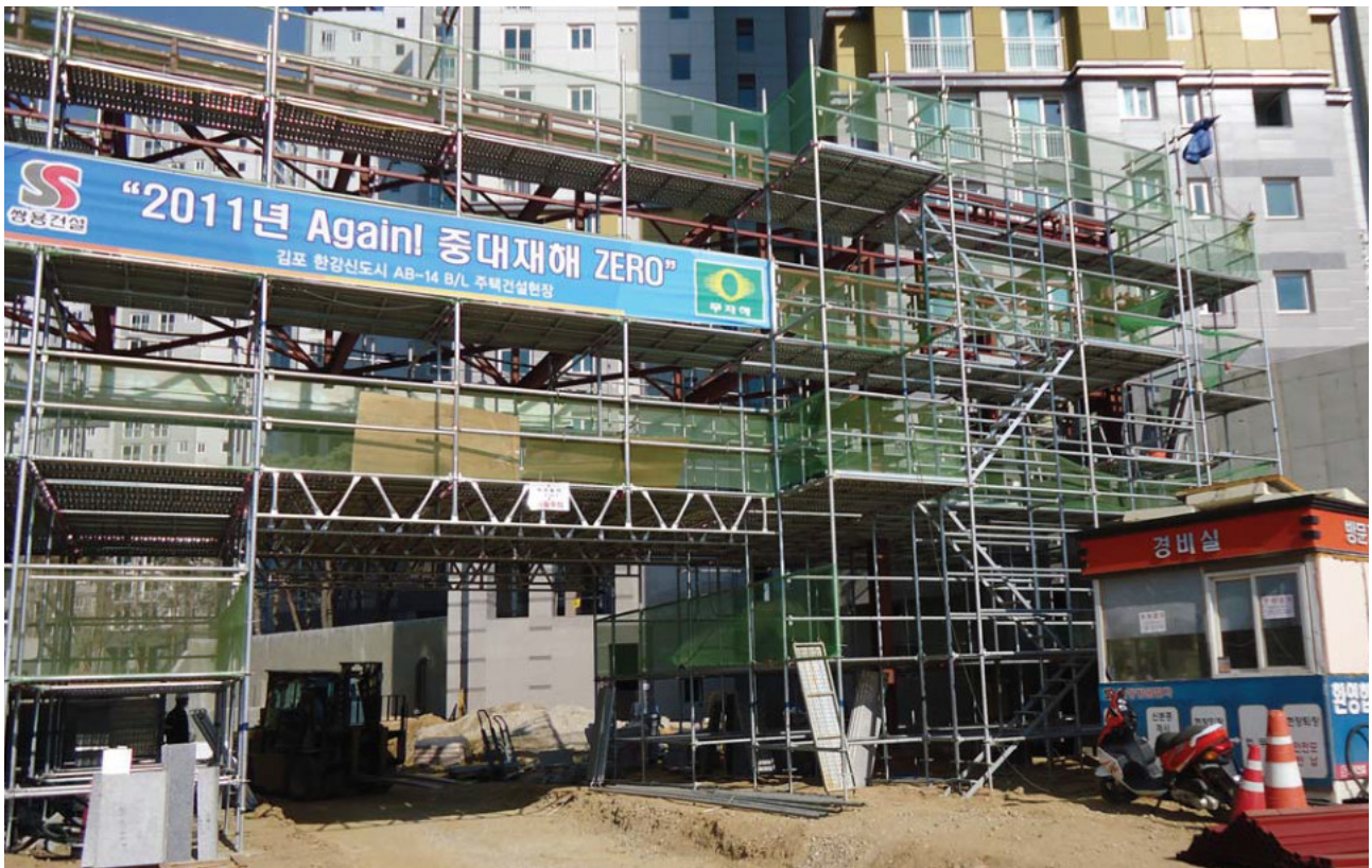
▲ Setting up TRUSS and ascending & descending makeshift stairs. / 트러스, 승강계단 설치
